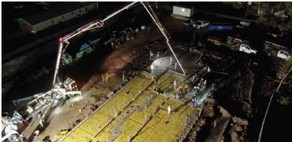
POURING THE FOUNDATION
